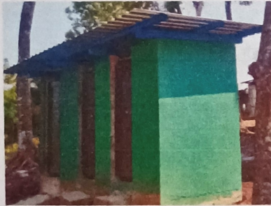
Foto 3: El modulo del baño se le cambio el entechado.
