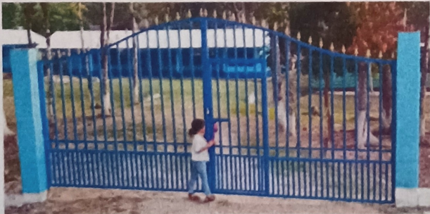
Foto 5: El portón es sustitido en sus totalidad.
